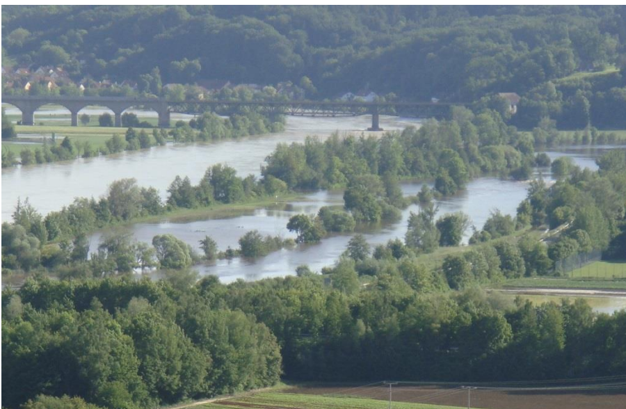
Insel versinkt im Strom beim Hochwasser 2013
