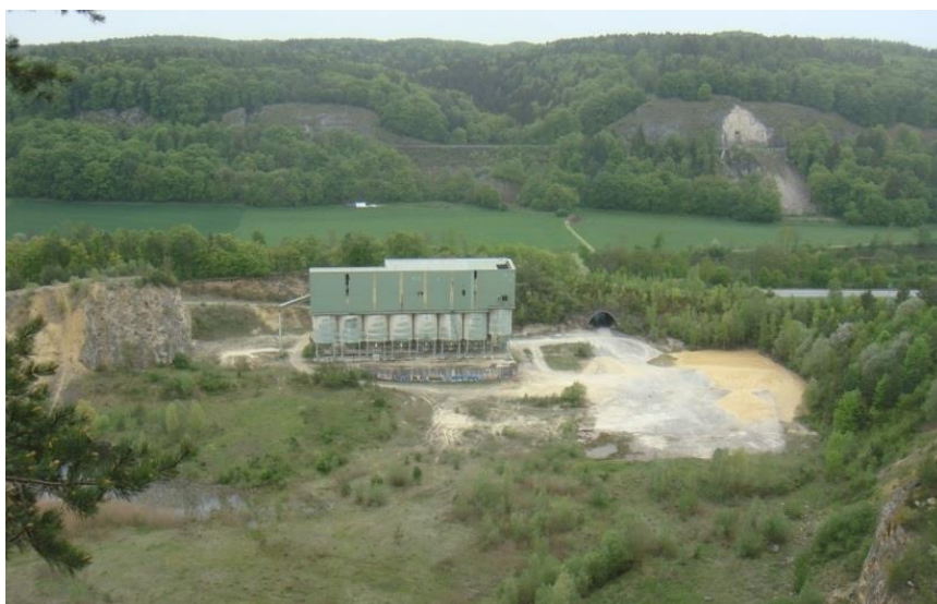
Auf der umrandeten Fläche stand bis vor kurzem noch eine Halle (Foto: BN Archiv)
