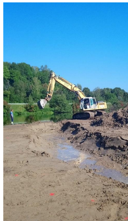
Das neue Altwasser wird gerade an die Alte Naab angeschlossen.
