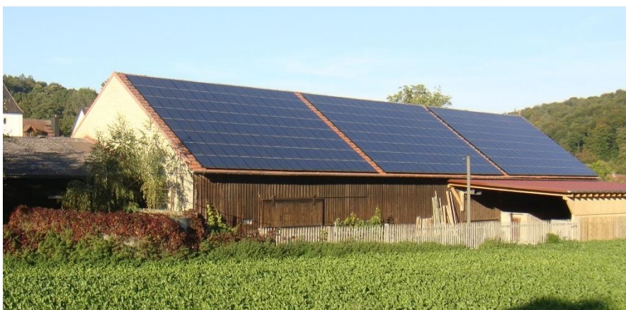
Ideal: PV-Dachflächenanlage in der Gde. Sinzing
