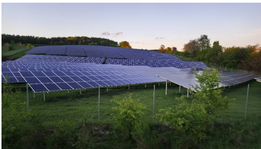
PV-Freiflächenanlage bei Pfaffenhofen; „gemäht“ durch Schafe
