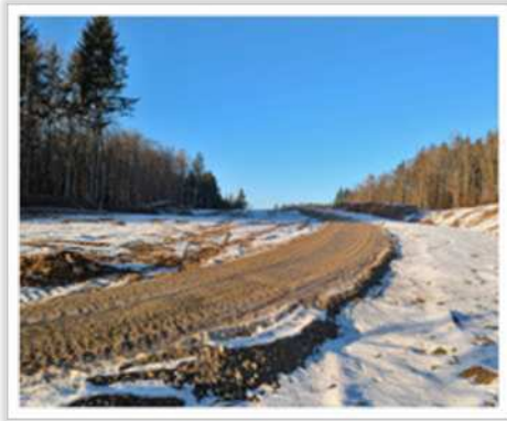
Schneise für den Süd-Ost-Link
