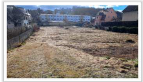
Prüfeninger Schlosstr. 17: Baufeld erfolgreich frei gemacht, kühlende Bäume sind weg
